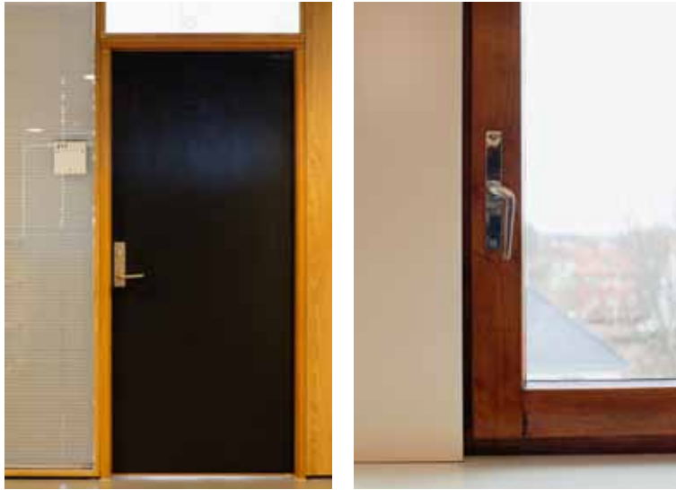
Rehabilitert dør og vindu.
