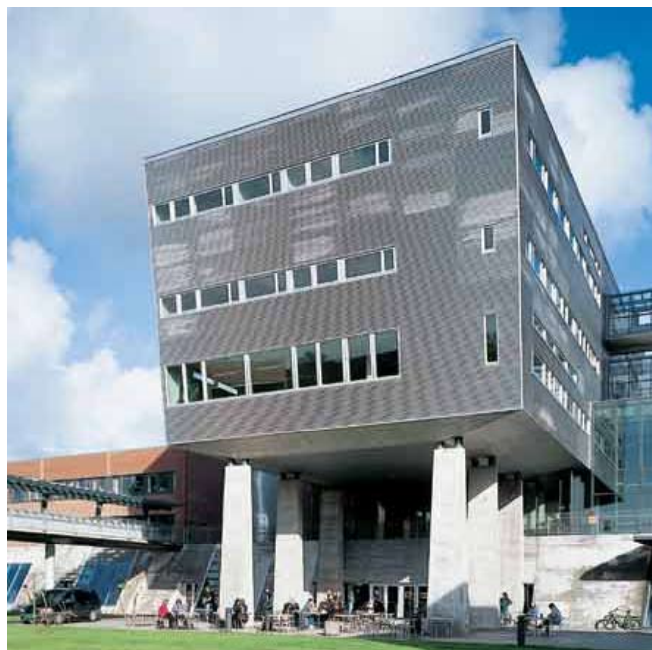
Høgskolen i Agder – med gjenbruk av forsvarsanlegg Foto: jaro.hollan@online.no
