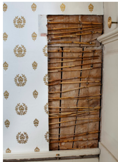
Fra Nystuen: Avdekking av rappet vegg som opprinnelig underlag for tapet.
