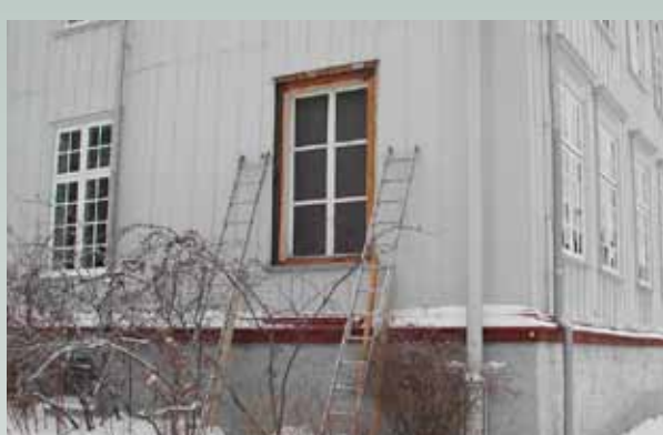
Østfasadens opprinnelige blindvindue fra tidlig 1800 avdekkes under de senere blindvinduene fra 1961.
