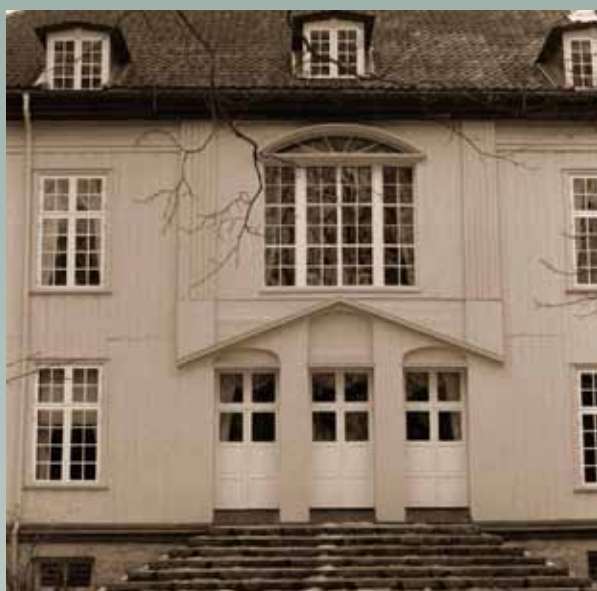
Hagefasaden fotografert etter endringene i 1961, med nye vinduer, ny hagetrapp og baldakinen fjernet. (Riksantikvaren)
