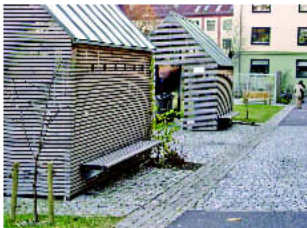
Åpen renne for bortledning av overvann fra tak og gangvei.
