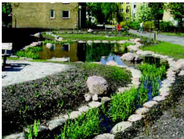
Nybygd åpen overvannsløsning i et boområde.
