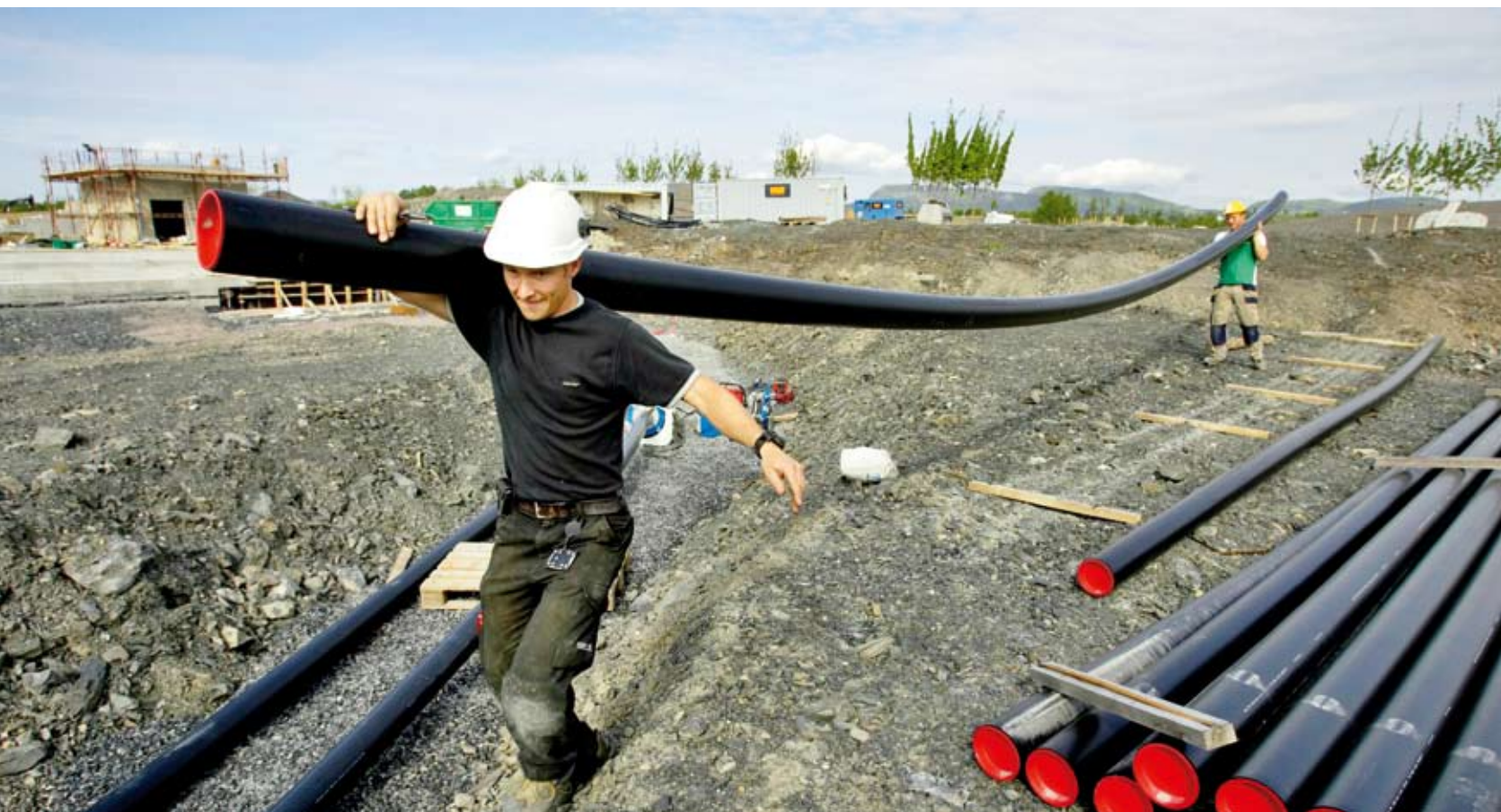
Rørleggerne Glenn Blom og Henrik Sunde Bakke fra Asker Rør legger rør til biorensanlegget som sørger for at vannet i kanaler og dammer er rent. Bildet til venstre: Beston Amin og Saman Ahmad fra Steen og Lund Anleggsgartner arbeider med dammen i sentralparken på Fornebu.
