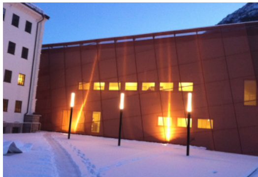
Foto: Egil Arnesen/Statsbygg
